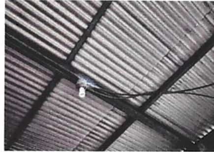
Foto 2: Mejoramiento del área de cocina, sustitución de lámina.
